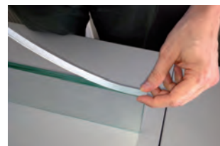
FIJACIÓN DE PAREDES DIVISORIAS DE VIDRIO
